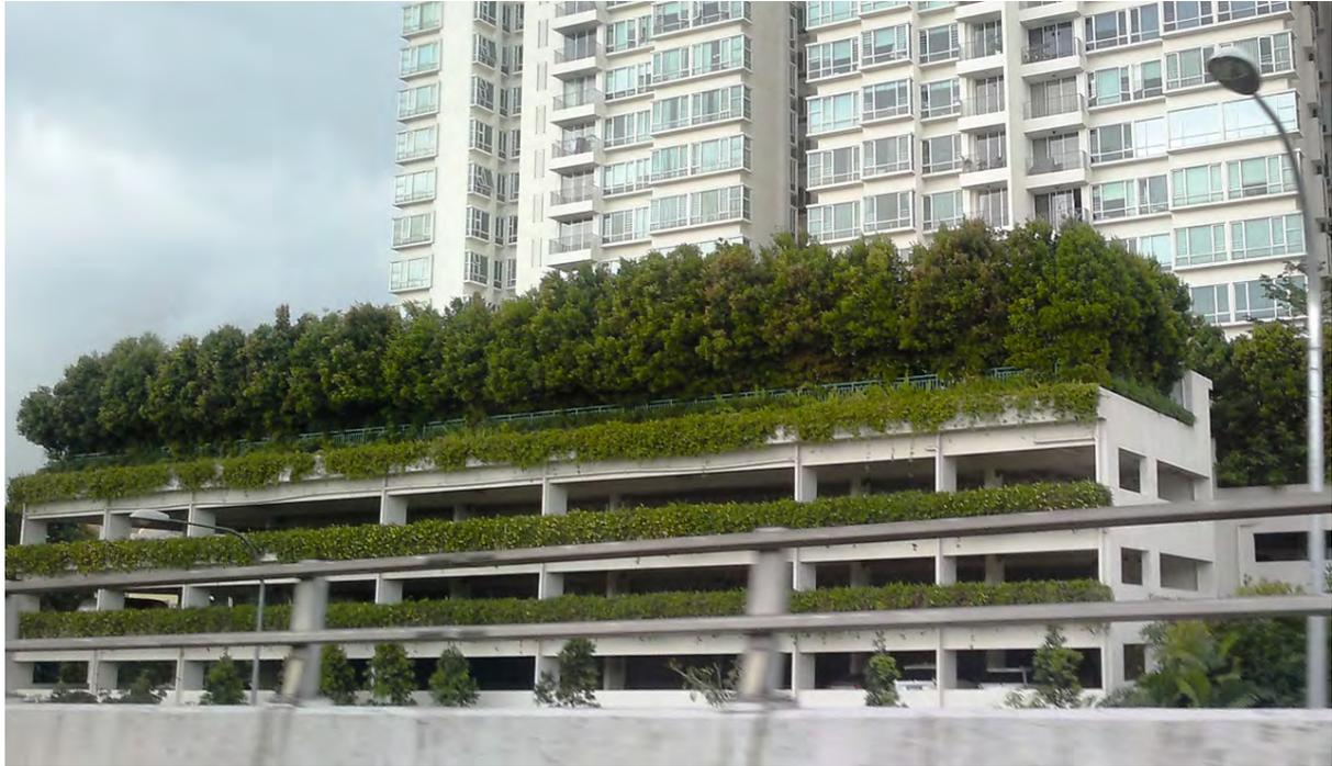
**Figure 4.11.10: Le mur vert contribue à réduire la fluctuation de la température diurne de la façade du bâtiment.**
