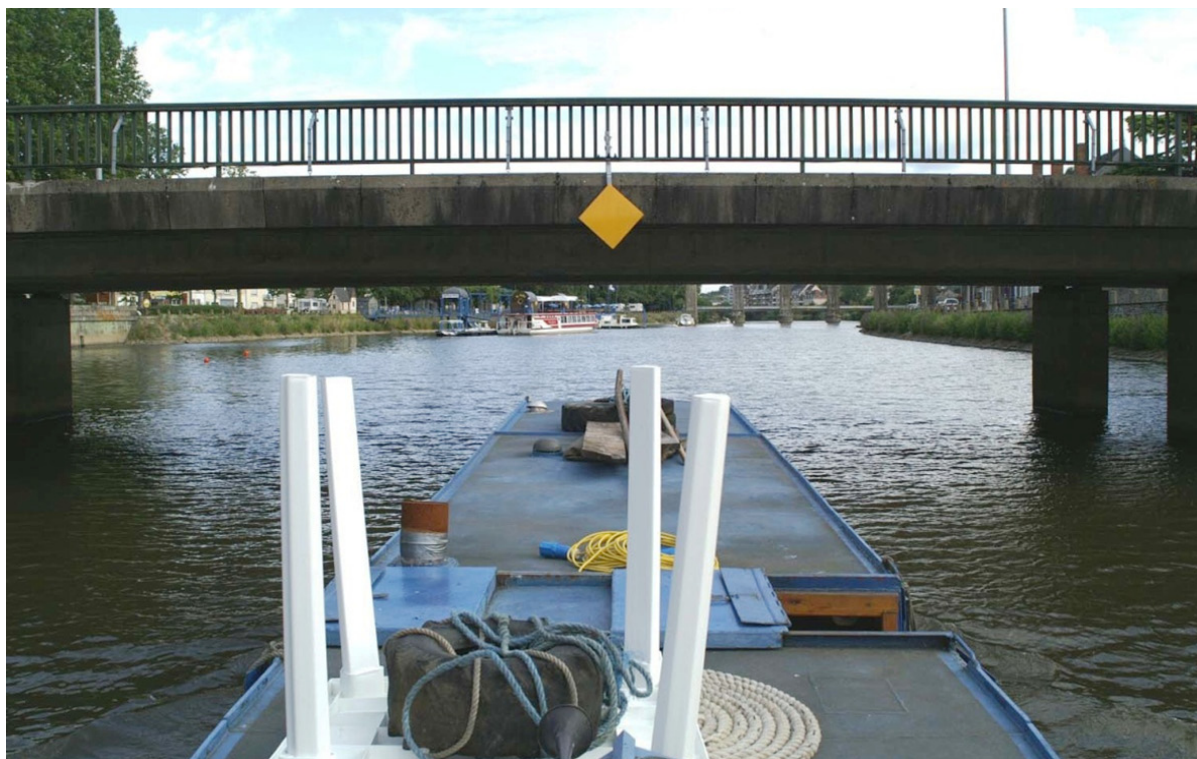
Рисунок 3.61: Высота моста должна учитывать подъем уровня воды и различные размеры судов
