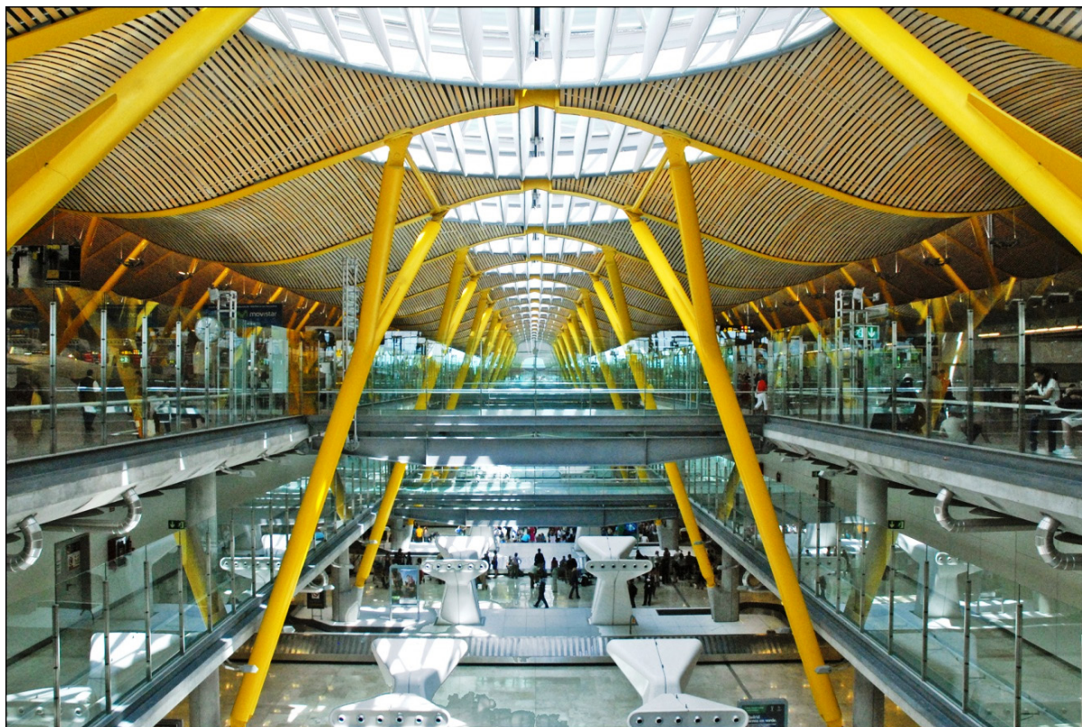
Рисунок 3.58: Мадридский аэропорт Барajas максимально увеличил использование естественного дневного света, одновременно уменьшая солнечное теплоступление за счет обширного внешнего затенения
